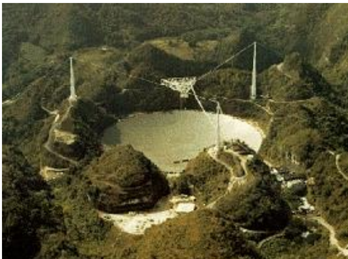
Гігантський радіотелескоп в Пуерто-Ріко. Антенною параболическої форми (діаметр 300 м) служить кратер недіючого вулкану; кратер забетоновано і покрито металічним шаром.
